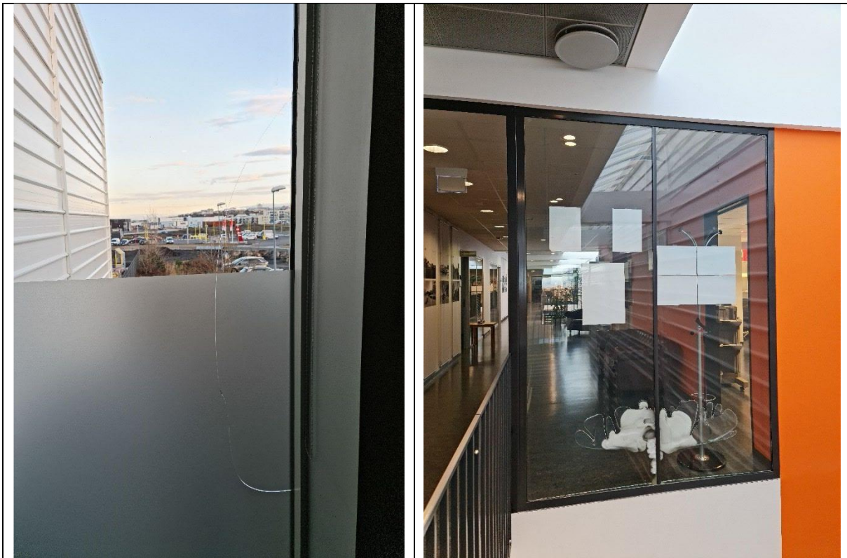
Mynd. Skipta þarf um öryggis- og eldvarnargler.
