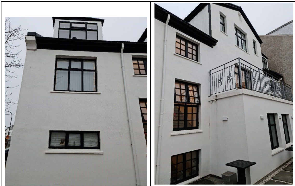
Myndir. Yfirfara þarf þéttingar með gluggum.
