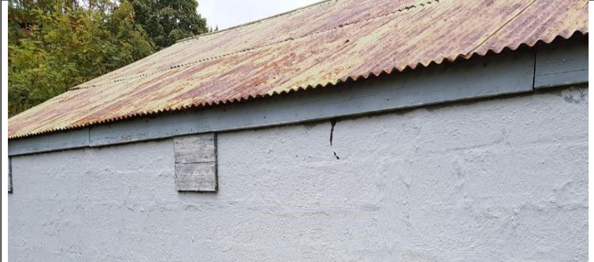
Myndir. Endurnýja þarf þakjárn..
